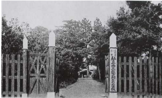
明治 39 年4月、竣工した校舎(現豊橋瓦町)
